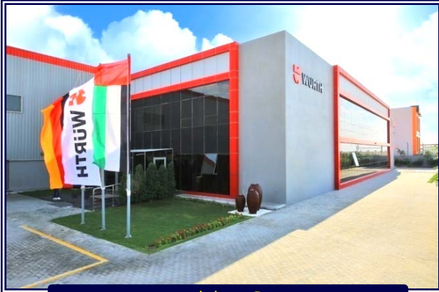
WURTH GULF WAREHOUSE
